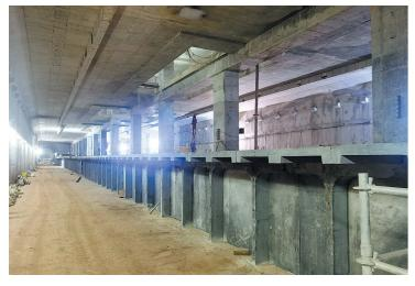
彭边站车站内部结构预制拼装完成 通讯员供图
