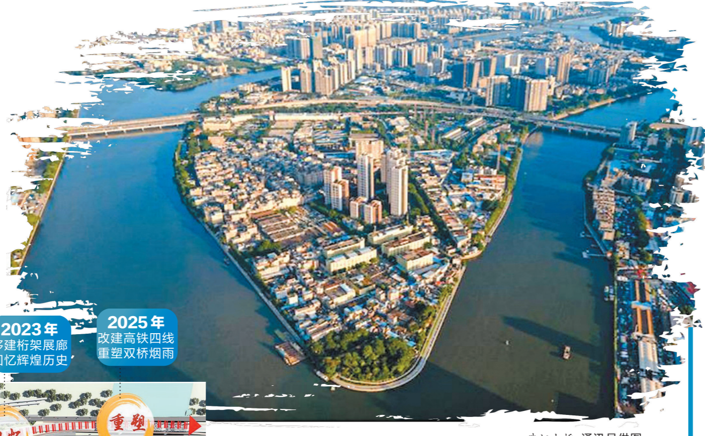
珠江大桥 通讯员供图
