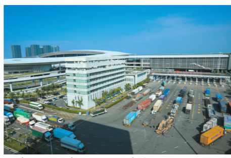
港珠澳大桥珠海公路口岸货运通道 受访者供图
