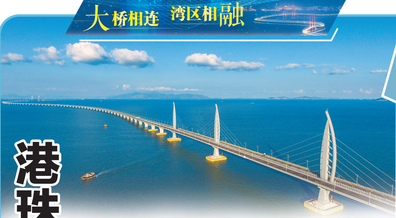
港珠澳大桥“巨龙”横跨伶仃洋 羊城晚报记者 宋金岭 摄
