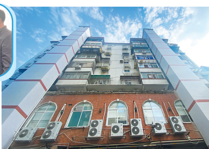
石牌东二街10号住宅楼加装好的两部电梯。
