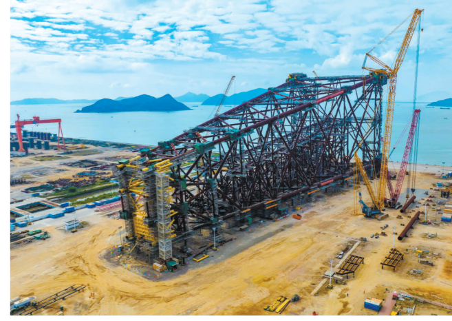
深水导管架“海基二号”成功封顶 刘聪 摄
