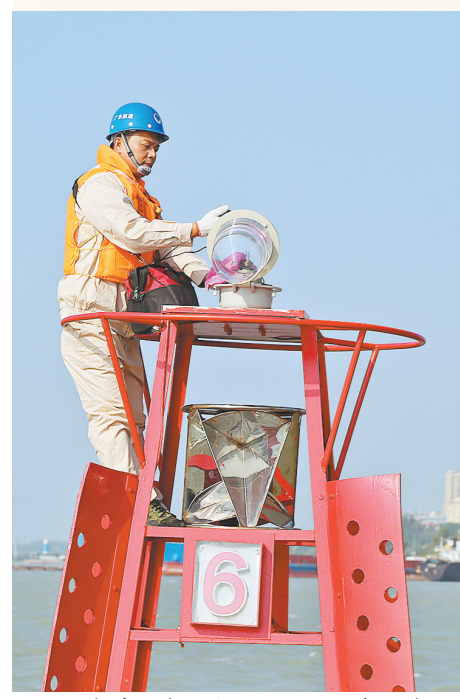
邱富养日常检查航标灯器及参数情况
