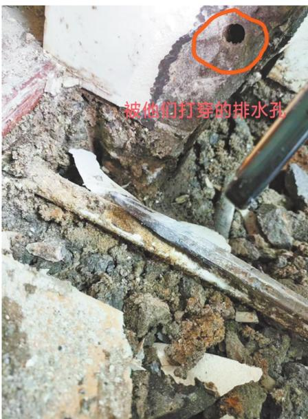
是在下水管道上开孔注胶,前维修人员钻孔的位置(受访者提供)
