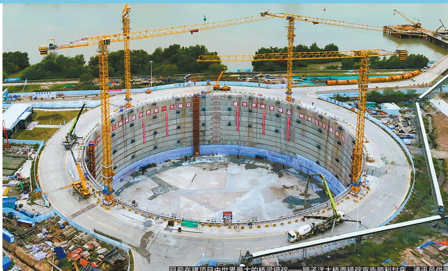
目前在建项目中世界最大的桥梁锚碇——狮子洋大桥西锚碇宣告顺利封底 通讯员供图
