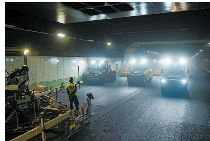
施工人员正在进行深中通道海底隧道沥青路面铺装 通讯员供图
