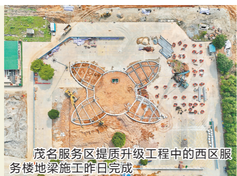
茂名服务区提质升级工程中的西区服务楼地梁施工昨日完成
