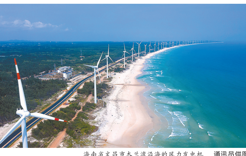
海南省文昌市木兰湾沿海的风力发电机 通讯员供图
