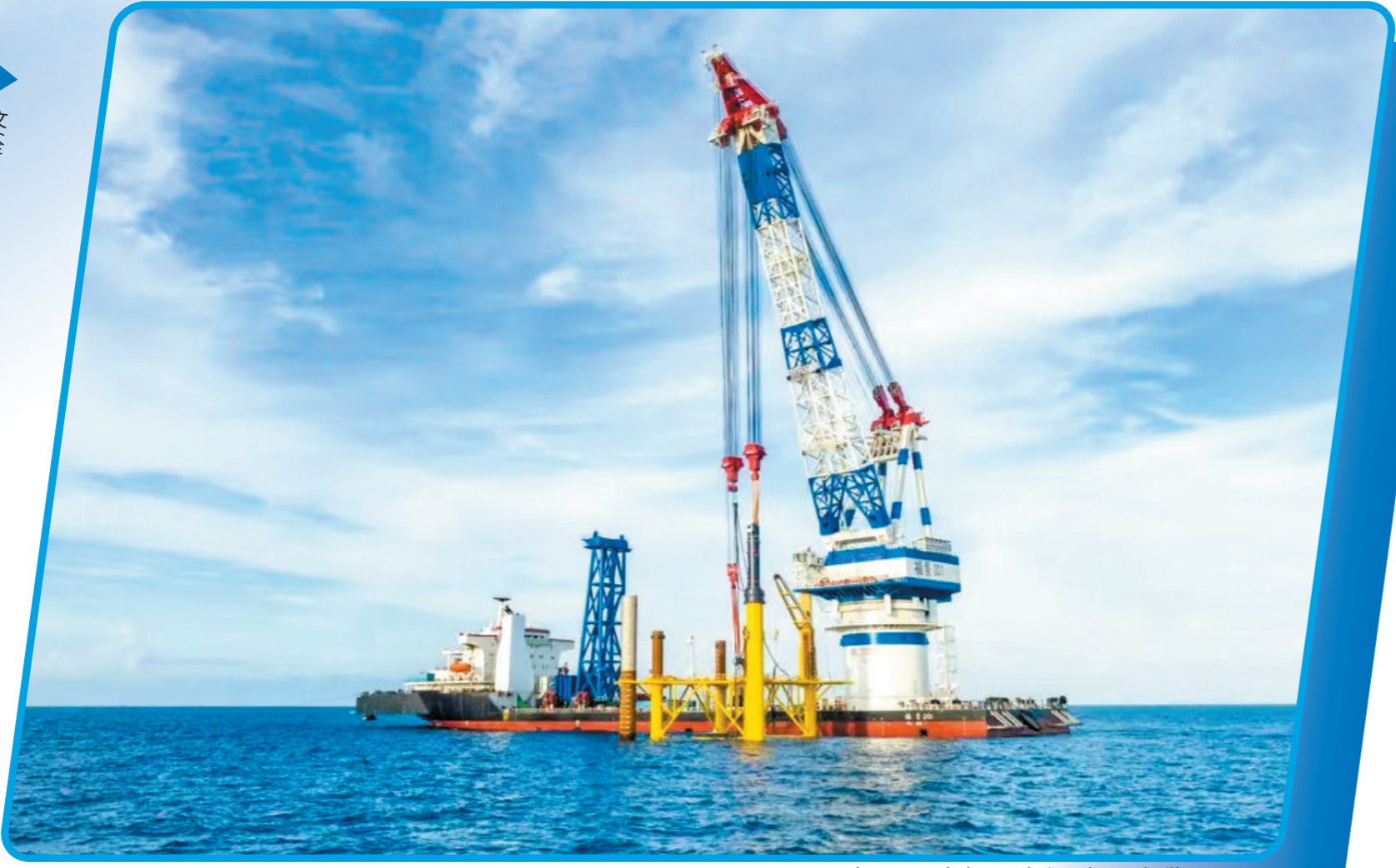
青洲项目 粤电阳江海上风电公司提供
