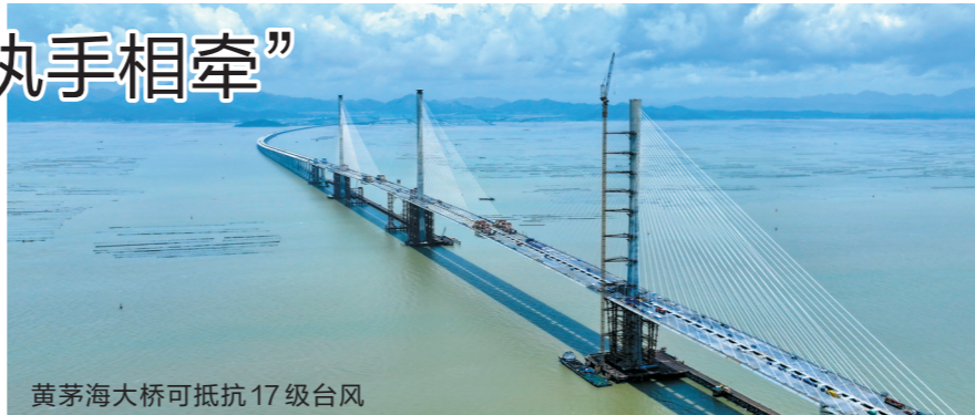
黄茅海大桥可抵抗17级台风
