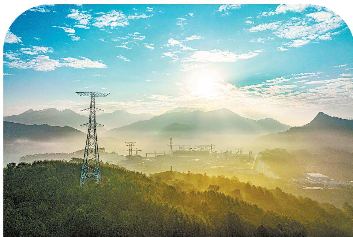
在国内首个网级互联、互通电力工程——500千伏网粤联网工程的建设期间，广东电网能源发展有限公司采用机械化、智能化的方式，全方位保障建设任务 陈海东 摄
