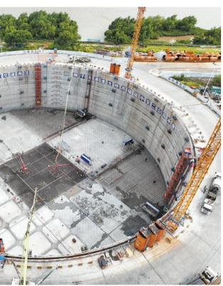
狮子洋大桥西锚碇按九宫格浇筑混凝土
