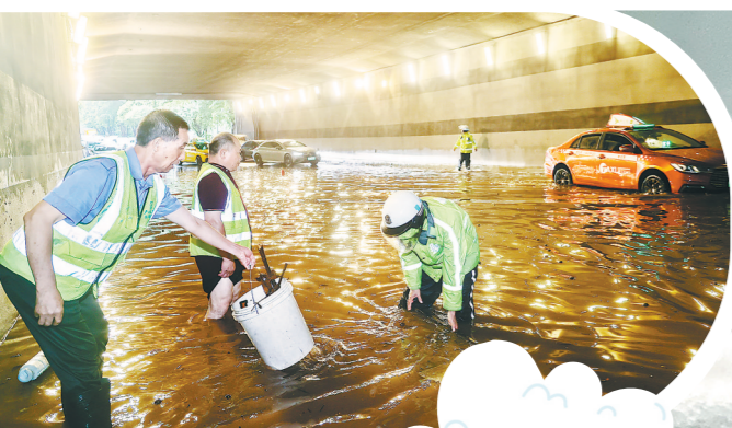
21日下午，广州市天河区科韵路黄埔大道立交隧道内积水情况严重，广州市交警支队天河大队等相关工作人员赶到现场清理积水。羊城晚报记者 刘畅 摄
