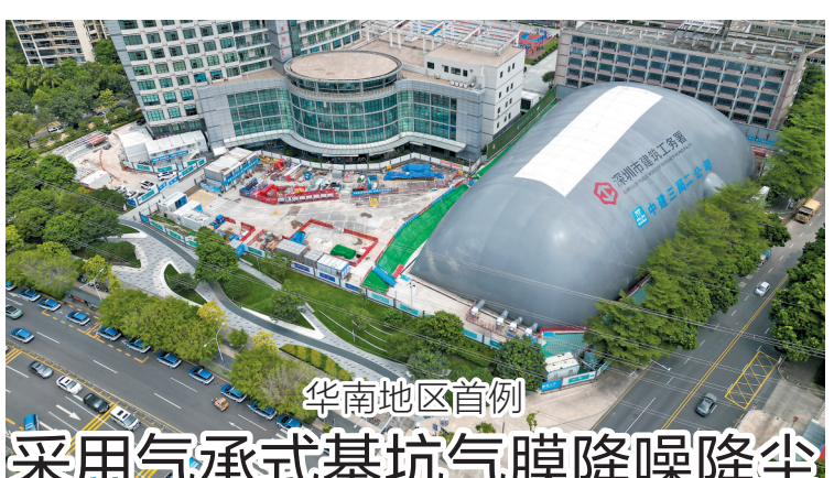
华南地区首例 采用气承式基坑气膜降噪降尘
