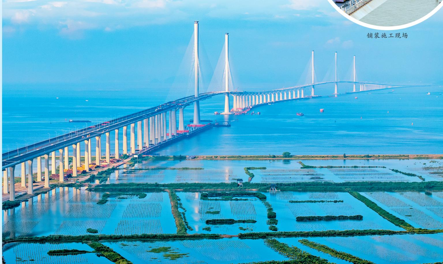
4日，黄茅海跨海通道高栏港大桥完成双幅环氧沥青铺装施工
