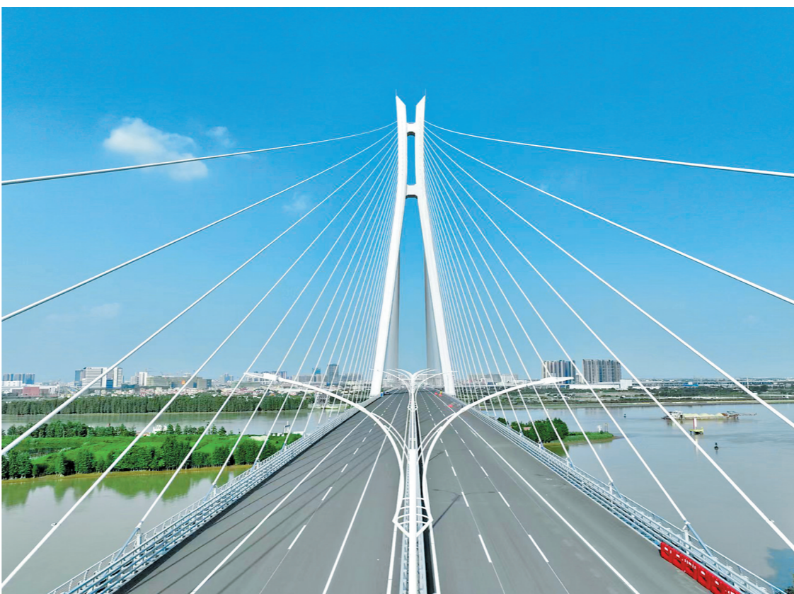
南中高速横门西特大桥 通讯员供图
