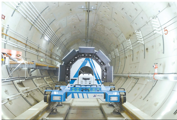
全地形隧道检测机器人在自动化工作中
