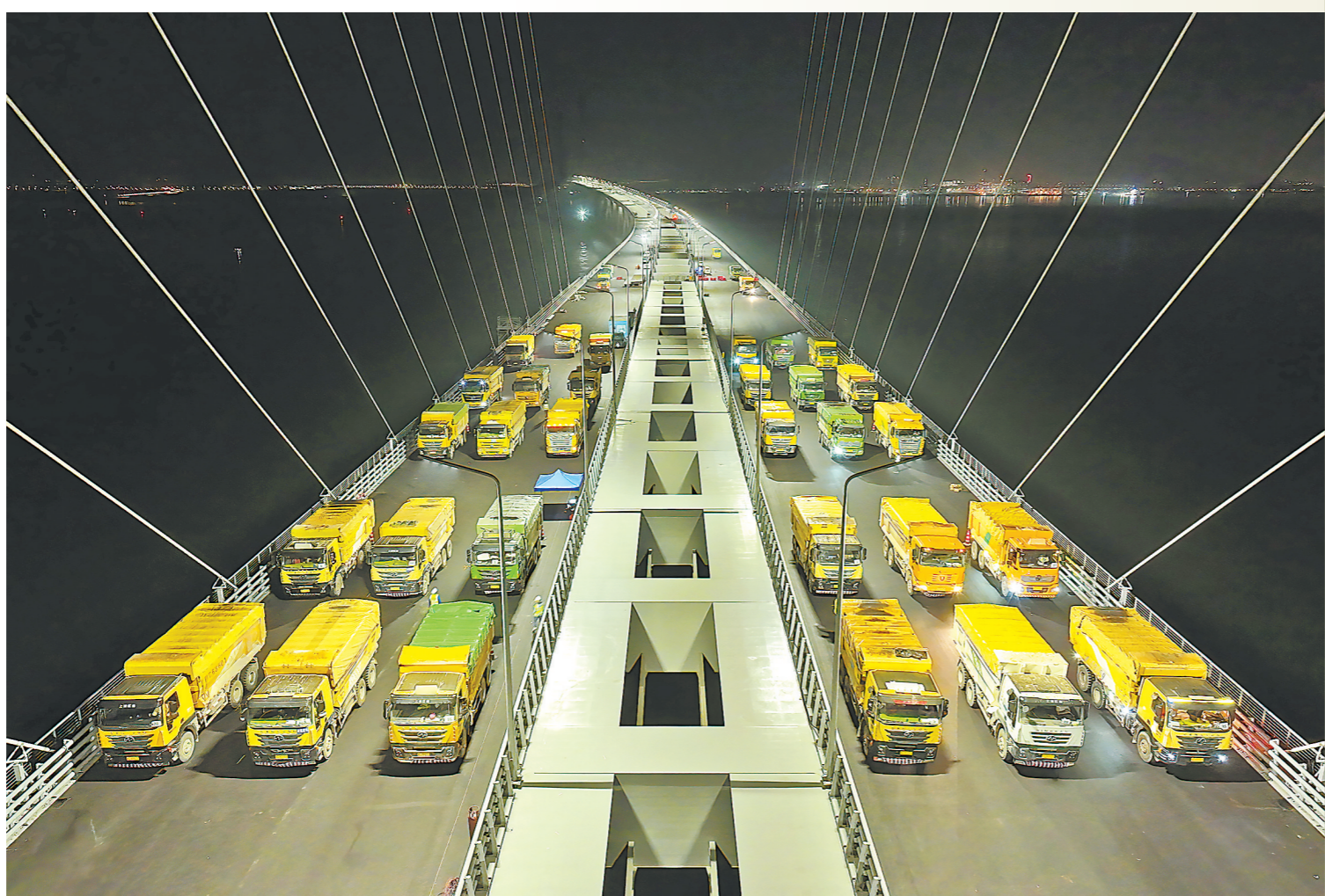
黄茅海跨海通道静载试验 通讯员郝笑天供图
