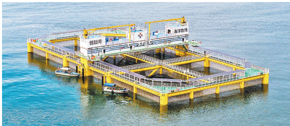
6万立方米水体的半潜锚泊桁架式智能养殖平台“恒鲙1号”在湛江市投入使用 湛江湾实验室提供
