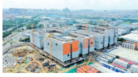
南方美谷一期项目(D区)封顶
