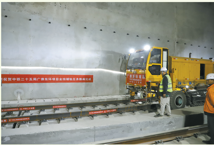
广佛东环城际建设现场,牵引车将最后一对长轨牵引合龙
