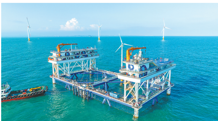
汕尾后湖风电场中心场区的“伏羲1号”风渔融合网箱平台 受访者供图
