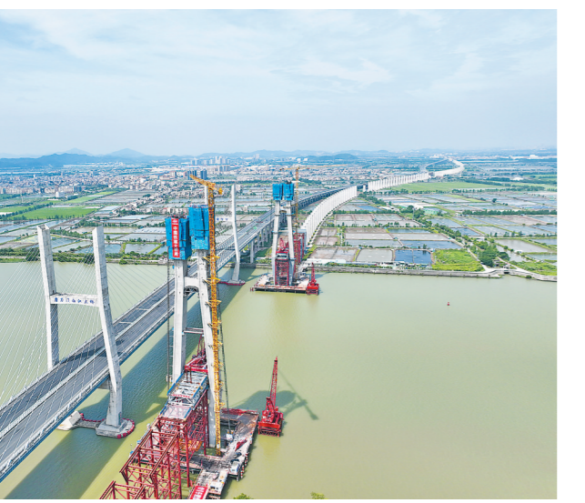
磨刀门水道主桥首个主塔封顶
