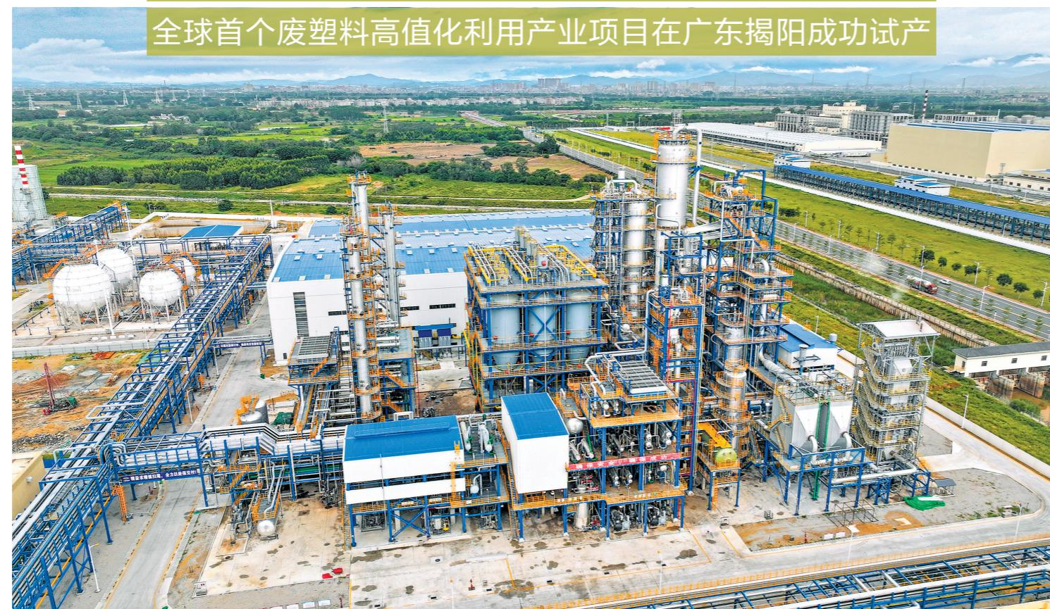
揭阳东华化学建设的混合废塑料深度裂解工业化装置
