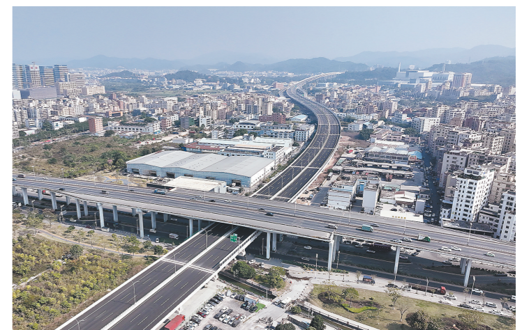
机场第二高速南段SG02合同段永兴特大桥 通讯员供图
