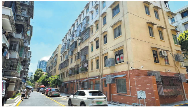
山顶片区老旧小区楼宇外立面重新粉刷
