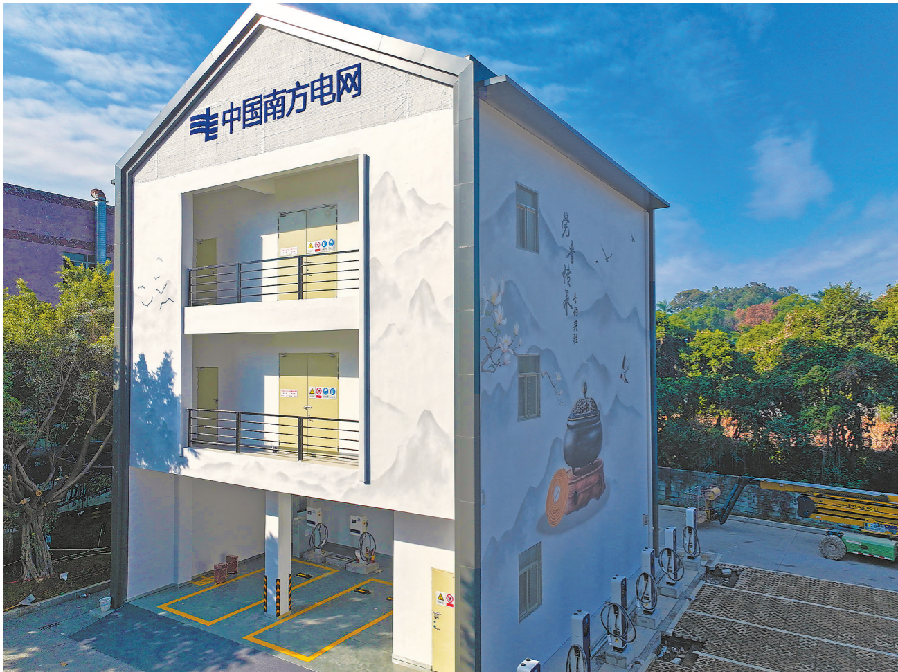
坐落在大岭山鸡翅岭村的低台区柔性互联项目 张翔 摄
