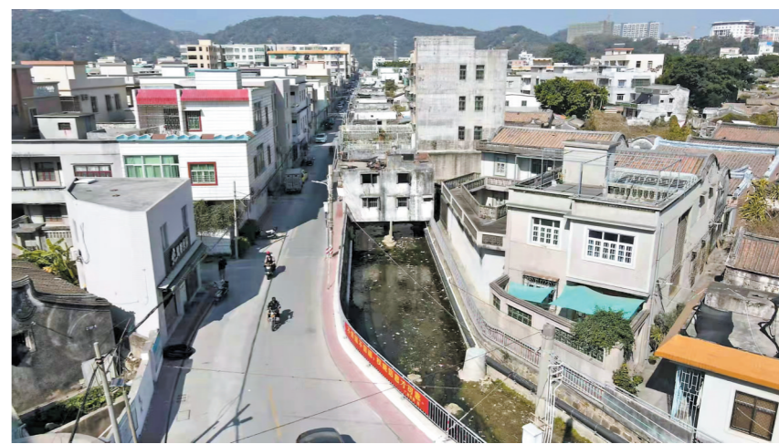
改造前的旧道与“臭水沟” 资料图
