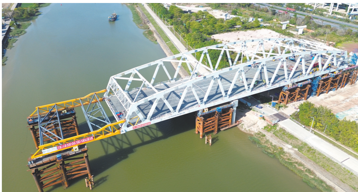
钢桁梁正进行梁段顶推作业 羊城晚报记者 曾育文 通讯员 李扬 摄
