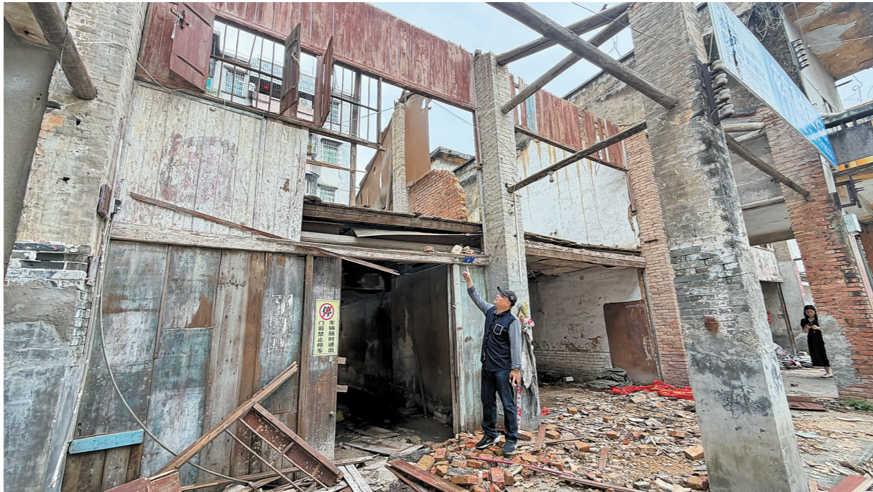
复兴街2号19号正在被拆除重建
