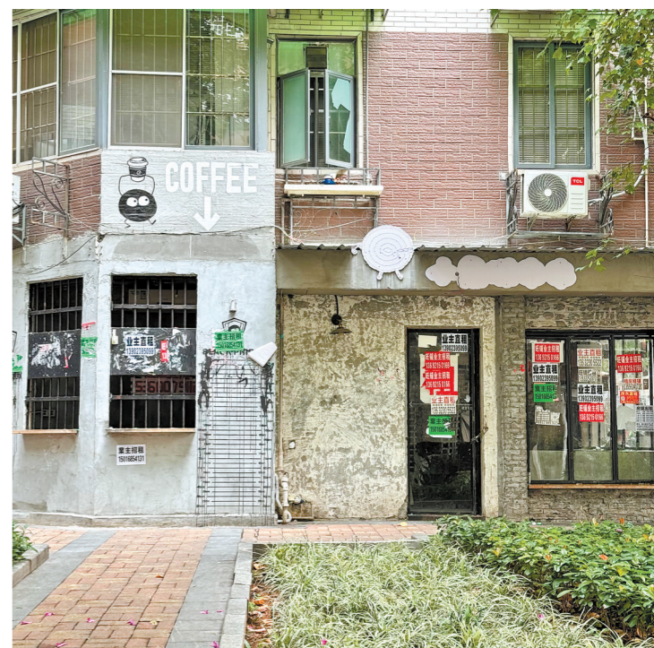
小区内已有部分商铺空置
