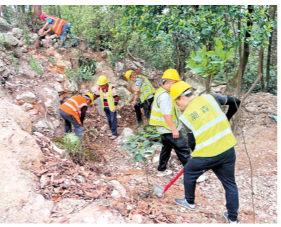
工作人员对沿线黄土裸露及采挖坑洞实施覆土复绿作业
