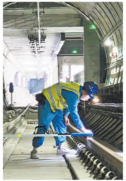
施工人员进行轨道精调 通讯员供图
