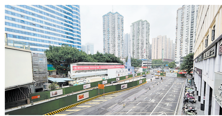
五羊邨站换乘通道施工区域即将实施围蔽 通讯员供图
