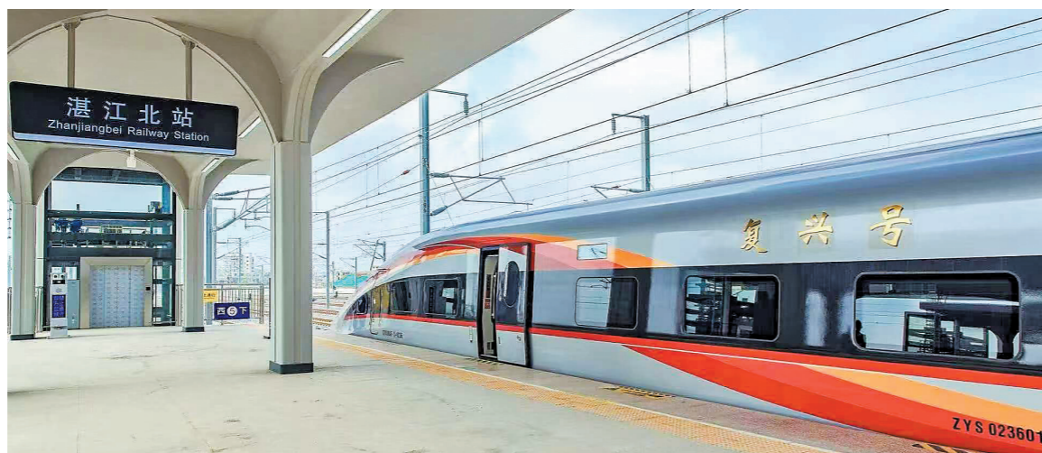
建设银行广州分行金融赋能铁路项目建设，助力湾区互联互通
