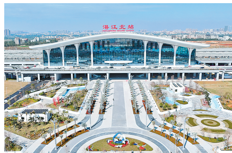
广湛高铁湛江北站
