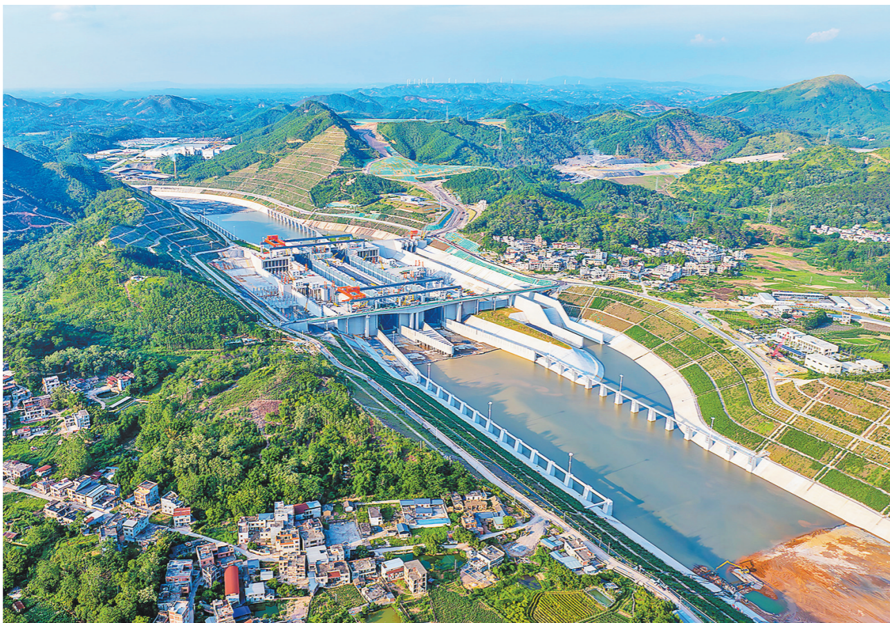
平陆运河马道枢纽充水现场 新华社发
