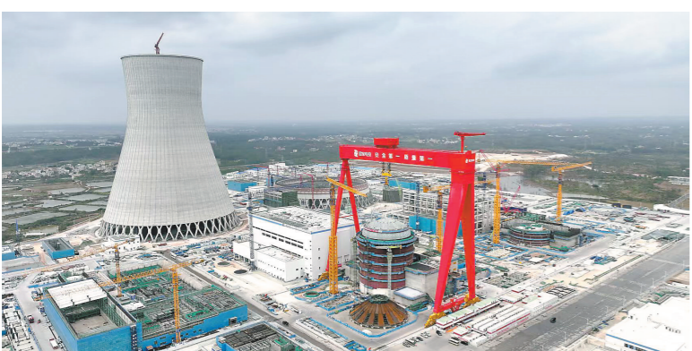
广东廉江核电项目施工现场 受访者供图
