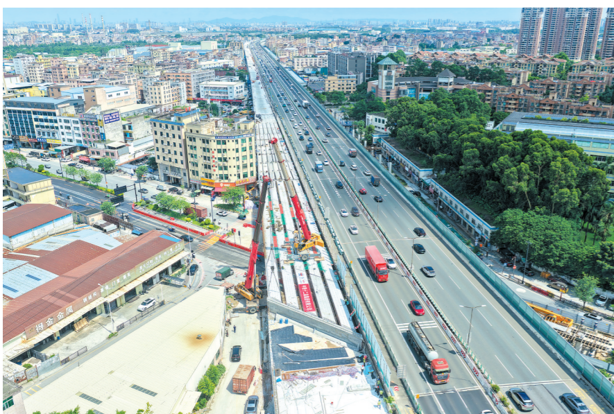
广深高速改扩建项目(穗莞段)D8高架桥左幅扩建侧完成预制梁架设 通讯员供图
