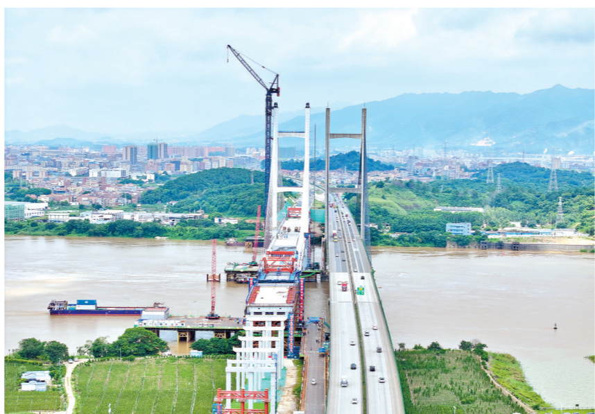
广肇高速新建金马大桥航拍图 羊城晚报记者 曾育文 摄
