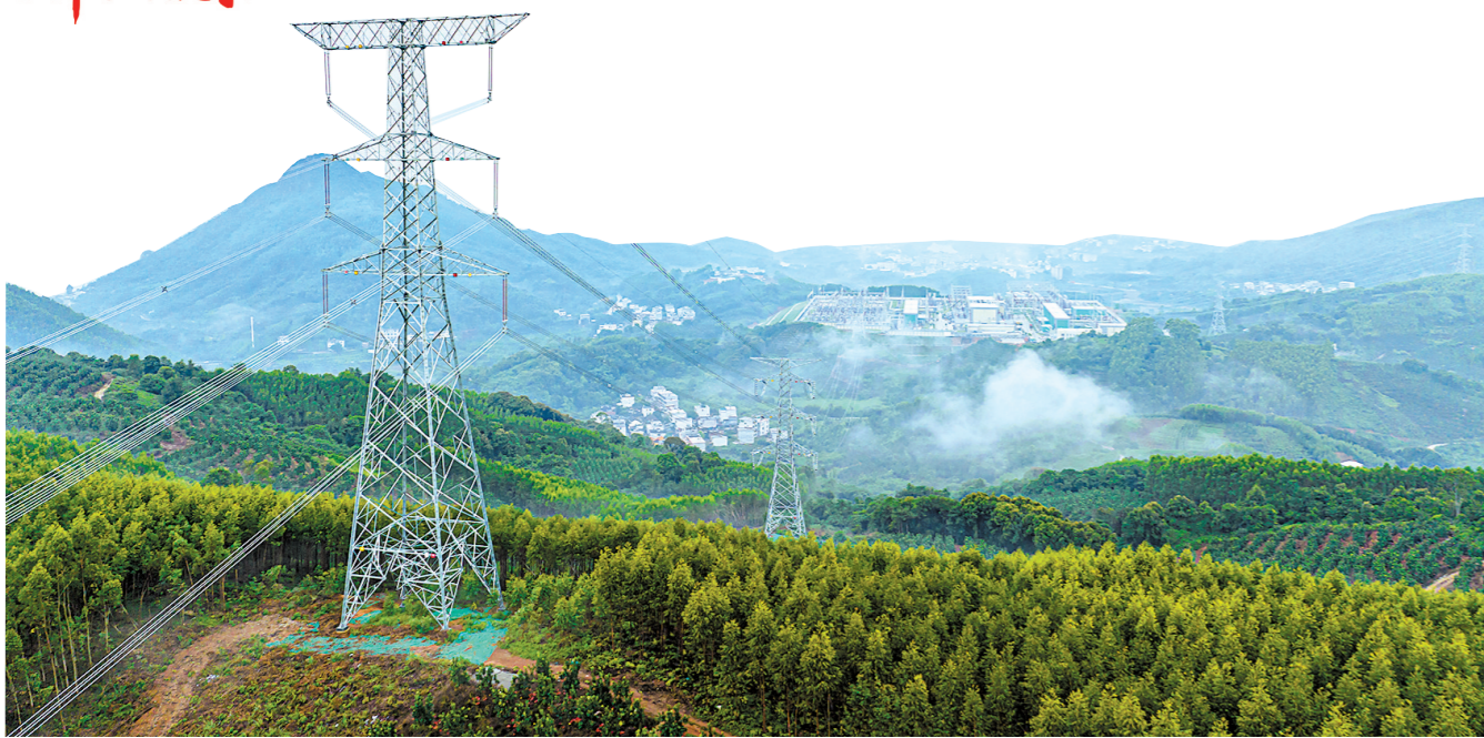
粤联网工程输电线路
