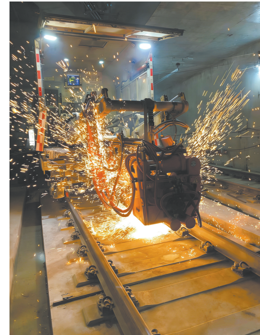
十二号线中段（景泰—东湖）长轨焊接 通讯员供图
