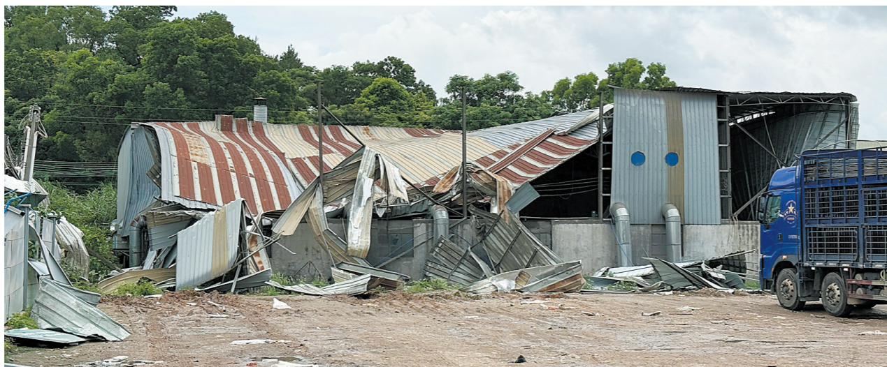
白云区江高镇受灾现场有多处房屋损毁
