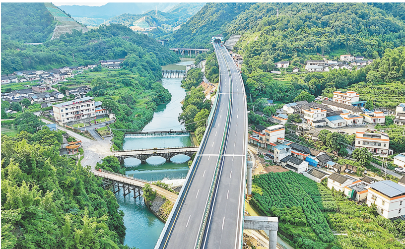
大桥与隧道顺利“牵手” 叶亦文 摄
