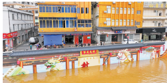
封开防洪堤外洪水滔滔，堤内居民生活如常 羊城晚报记者 周巍 摄
