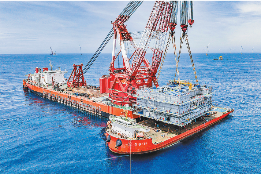
“振华30”起重船将海上电力核心平台稳稳吊起 受访者供图
