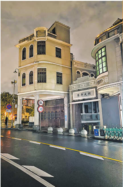
恩宁路骑楼外墙安装了路灯，但部分不亮
