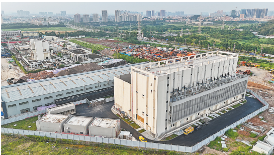
220千伏茶山(石埗)输变电工程竣工投产
