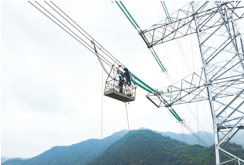
500千伏嘉岐甲乙线与嘉敬甲乙线交叉跨越改造
