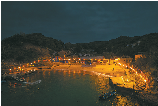
南方电网广东惠州供电局三门岛微电网第三期工程建成投产
