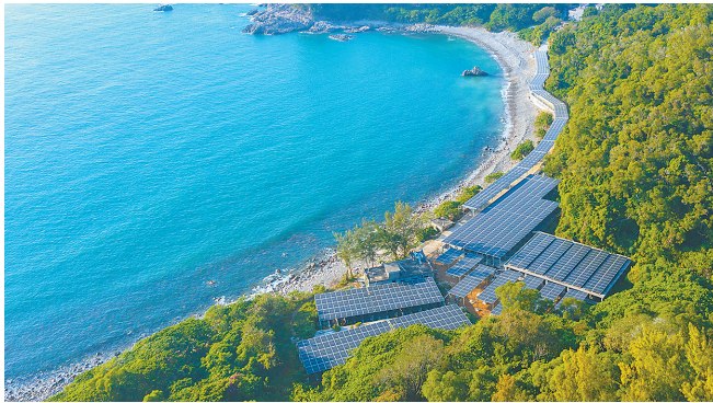
碧海青山间,三门岛微电网光伏阵列沿环海岸线铺设,勾勒出一幅美丽的清洁能源新图景
